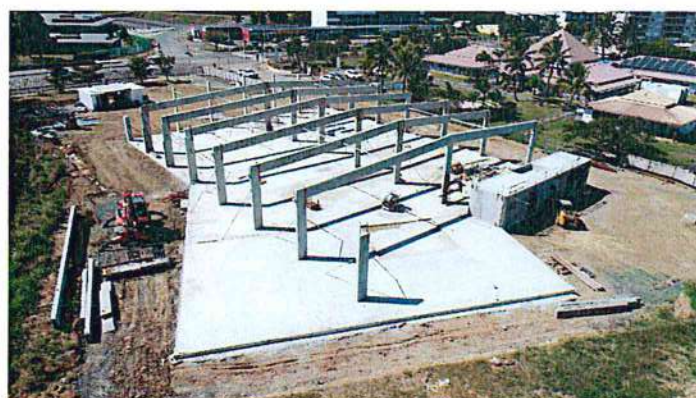
Pose de la charpente béton août 2023
